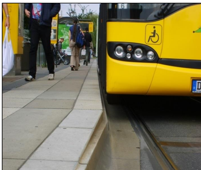
Rys. 8.6.1. Zalecane ukształtowanie krawędzi peronowej.
